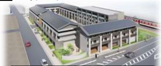
桜井県営住宅(1期)の建替
