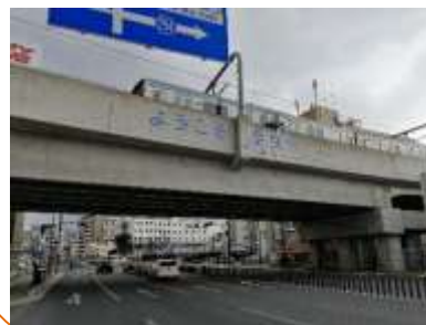
JR高架橋(西面)
