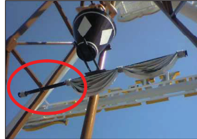
ロープ（両端2か所をリベットで固定）
