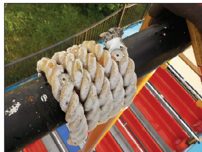
ロープ（両端2か所をリベットで固定）
