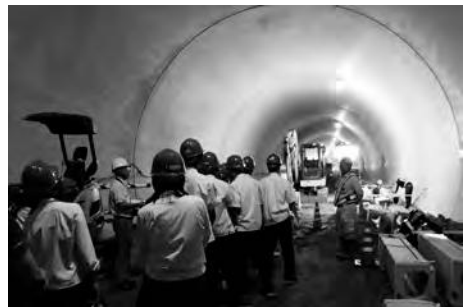
高取バイパストンネル工事現場の見学
