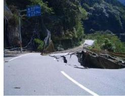
写真B: 道路崩壊による通行止め
