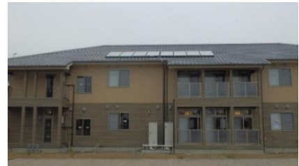
福祉施設への太陽熱利用システムの導入
