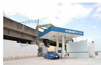
北大阪水素ステーション
