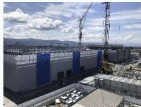
工事状況(2019年6月上旬)
