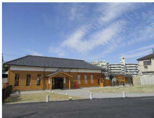
奈良市京終駅観光案内所(竣工後)
