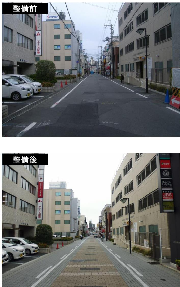
図 7 「安全・円滑な交通確保」の観点に基づく無電柱化の整備事例
