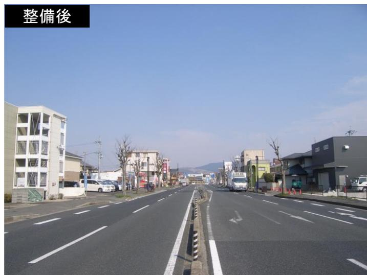
図 6 「防災」の観点に基づく無電柱化の整備事例(奈良生駒線(大宮通り))
