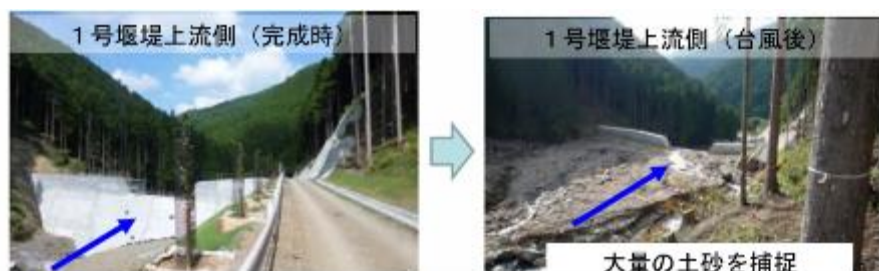
写真-3 1号堰堤の整備効果
