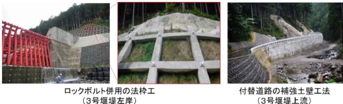
写真-2 3号堰堤左岸付近の工法
