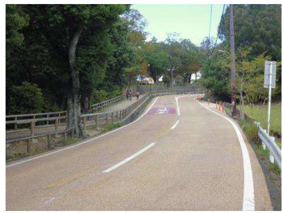
公園内道路のカラー舗装化
