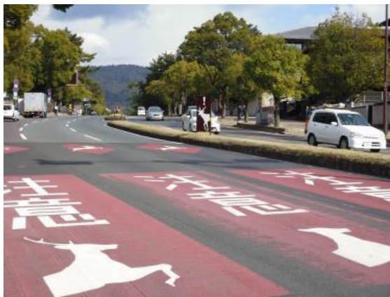
路面標示による注意喚起
