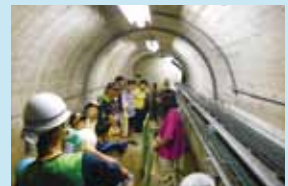
ダム堤体内を見学
