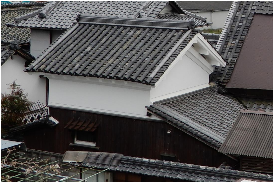
荘司家住宅内蔵 北西より（安堵町教育委員会提供）
