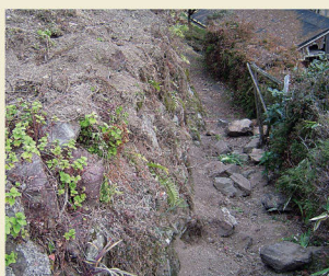
イノシシによる石垣の破壊
