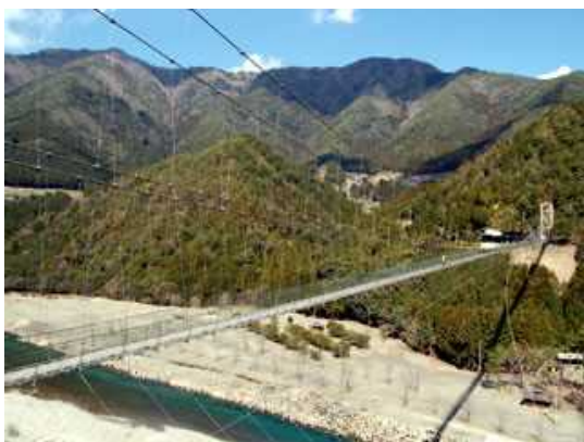
谷瀬の吊り橋 出典: 十津川村役場
