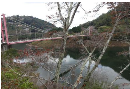
▲ 現地調査状況：地衣類が多数着生している
