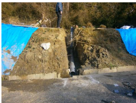
▲ 重機を使って古墳池の水路の確保
