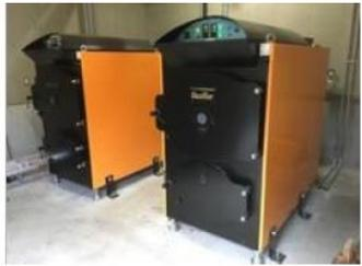
①集積された薪 → ②温泉施設へ薪を供給 → ③薪ボイラーによる熱供給
