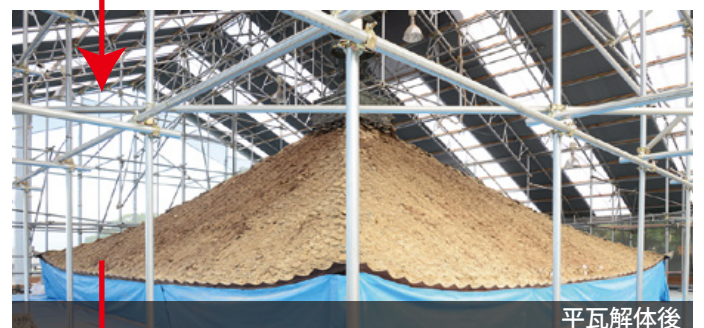
丸瓦下葺土撤去後
