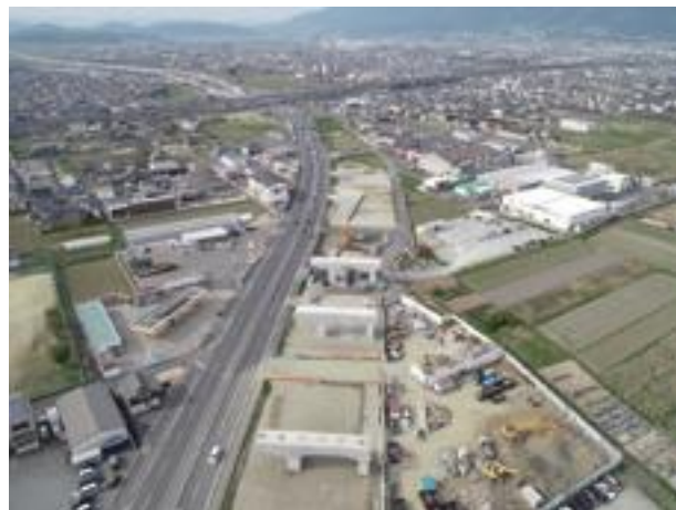
▲大和御所道路 (橿原北IC～橿原高田IC)の工事状況
