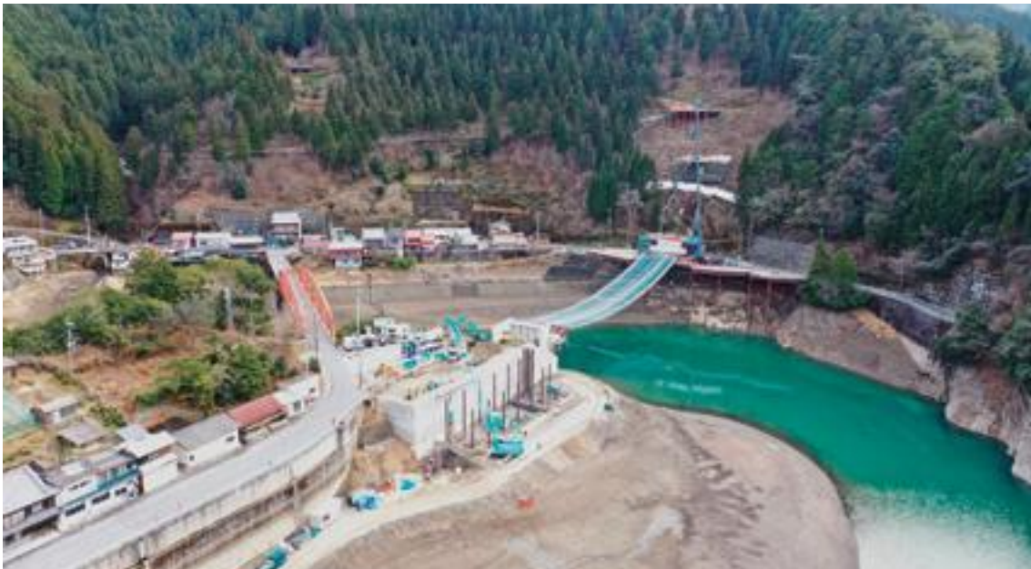
国道168号(仮称)新阪本橋の工事現場(五條市)
