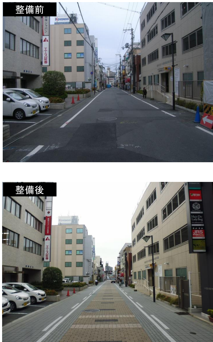
図 7 「安全・円滑な交通確保」の観点に基づく無電柱化の整備事例 (大和八木停車場線)
