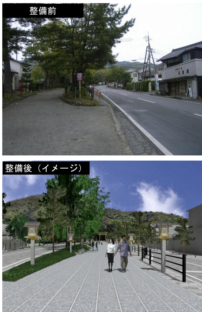
図 9 「県と市町村とのまちづくり」の観点に基づく無電柱化の整備事例 (三輪山線)
