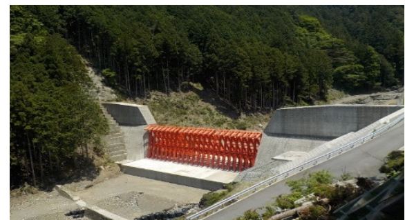
砂防設備の設置
