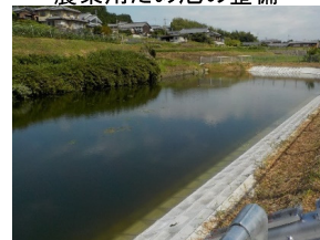
農業用ため池の整備
