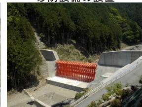
砂防設備の設置
