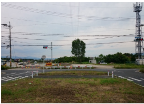
②結崎田原本線(結崎~三河工区)北側
