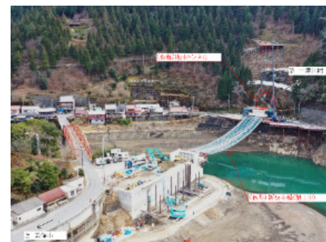
③阪本工区(北側の整備状況)
