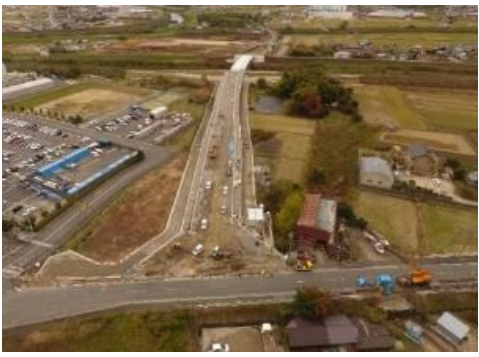
③天理王寺線(長楽工区)東側 (R元年度供用箇所)
