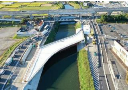
①枚方大和郡山線(中町工区)南側 (R元年度部分供用予定箇所)
