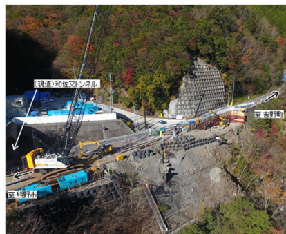
①伯母峯峠道路(仮称)2号橋 (橋梁下部工工事)
