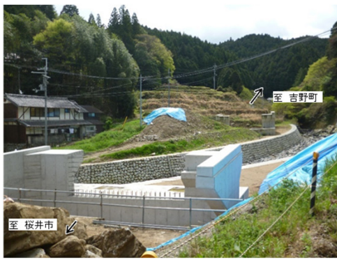
②百市工区(橋梁下部工事)
