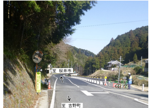
③百市工区(部分供用状況)
