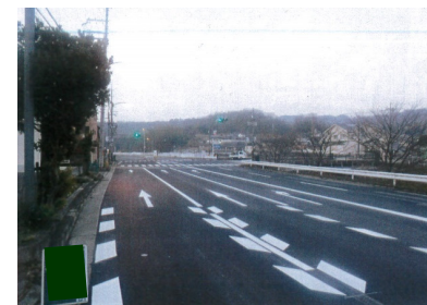
区画線が施工された道路
