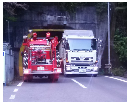
②新伯母峯トンネル (現道における大型車のすれ違い状況)
