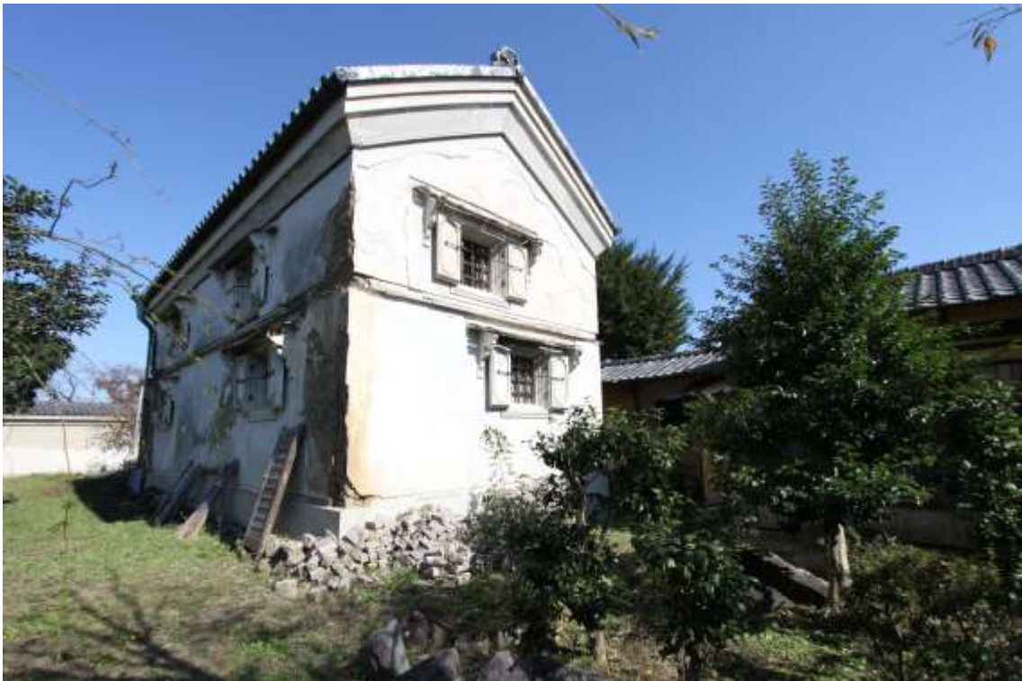
岡橋家住宅内蔵 外観（橿原市教育委員会提供）
