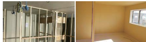
間仕切壁施工
