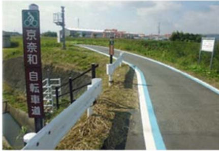
案内誘導サイン（ルート名称等）、注意喚起サイン、ブルーライン
