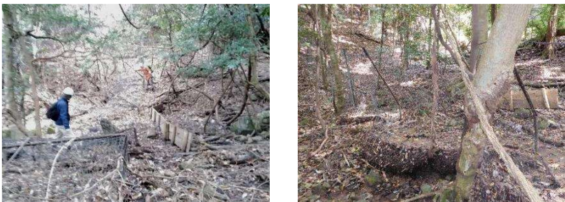
図27 「春日山16-2」植生保護柵内の様子
