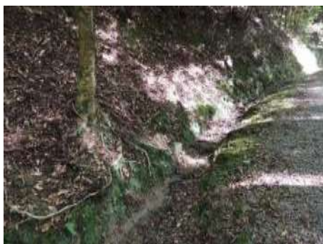
斜面下部。歩道に面している。
