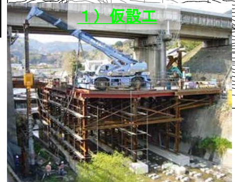
ダウンザホールハンマーによる支柱打設
