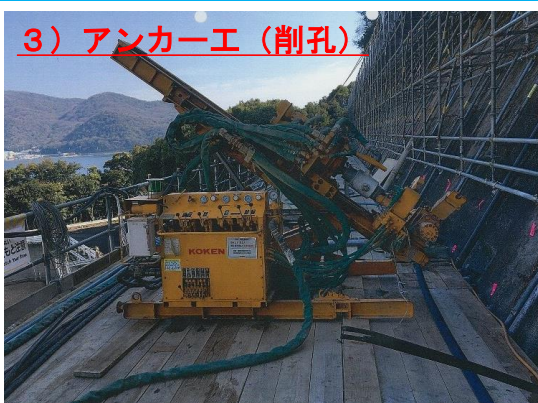
ロータリーパーカッションによる削孔
