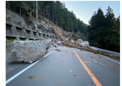
国道168号五條新宮道路長殿道路事業中間
