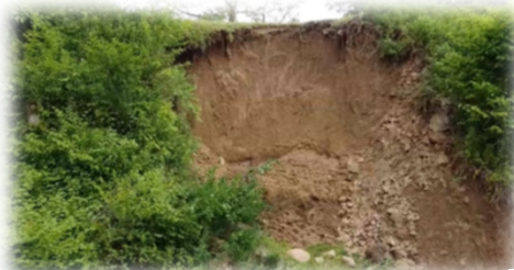
※北側崩落地（令和5年崩落）
