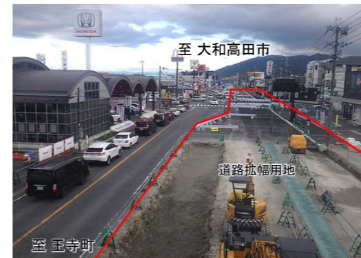
一般国道168号（香芝王寺道路）（香芝市） 地方創生、国土強靱化等のため、県土の骨格を形成する道路整備を推進
