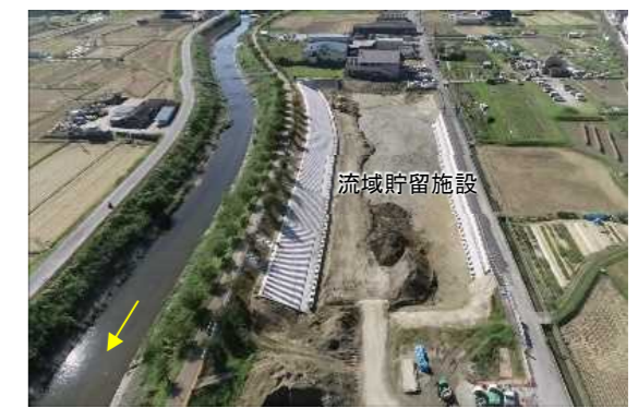
内水対策のため流域貯留施設を整備（王寺町）
