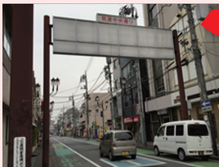
撤去されずに残されたアーチ看板
