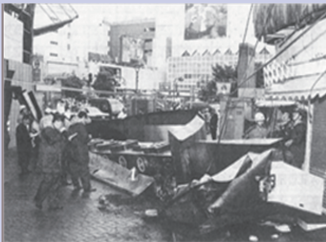
台風で落下した時の様子
