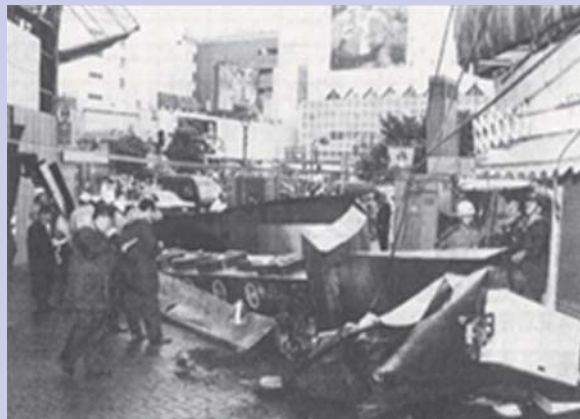
台風で落下した時の様子
