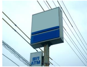
鉄骨接合部（溶接部）が腐食している状態
