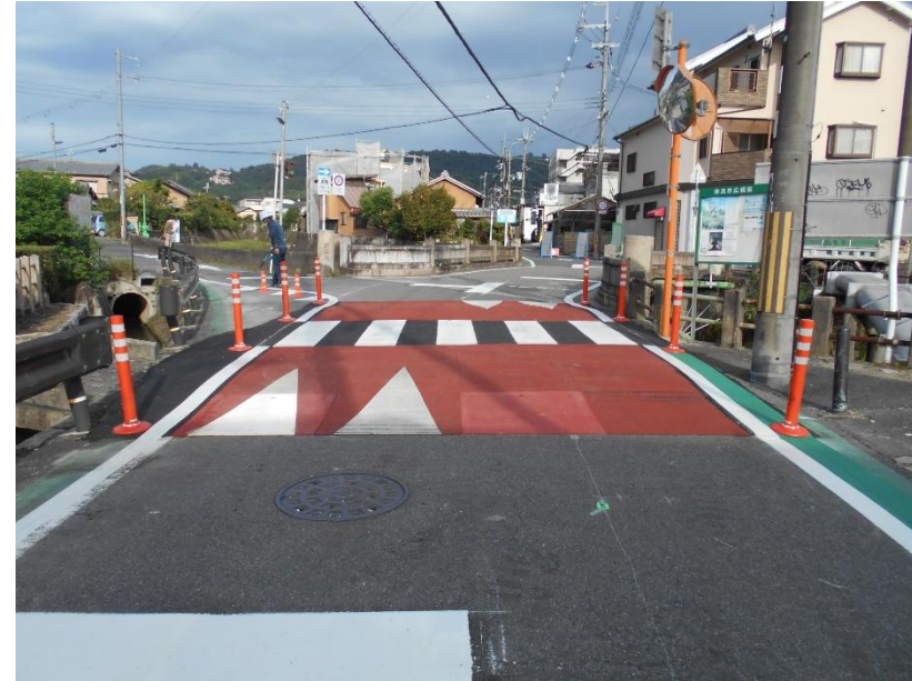
▲一般県道谷田奈良線（奈良市法蓮町）のスムーズ横断歩道（仮設ハンプ）設置（令和3年度）
