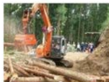
高性能林業機械による作業
