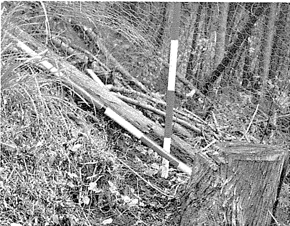
図10 シカが潜り抜けて網と地面に大きな隙間が生じた防護柵 (一度生じた隙間はシカの通路となるので修理が必要。)
