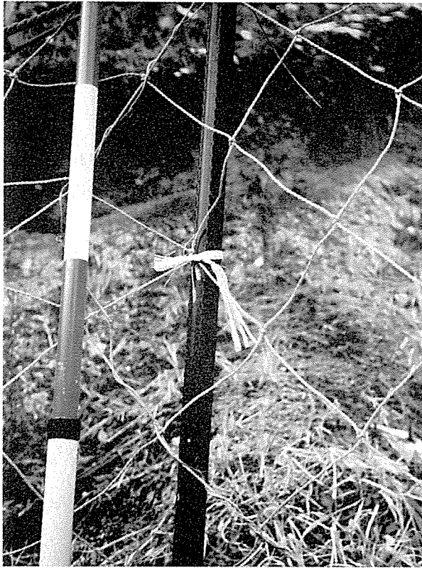
図3 合成繊維ネット、軽量化鉄パイプが使用されている防護柵 (網はポリエチレンにステンレス線を編み込んだものである。)
