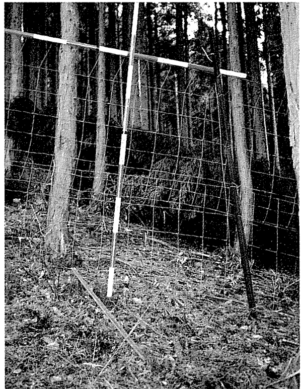
図1 格子状金網、鉄製L型資材が使用されている防護柵（網、支柱は強固なものであるが、高さは約1.5mとやや低い。）
