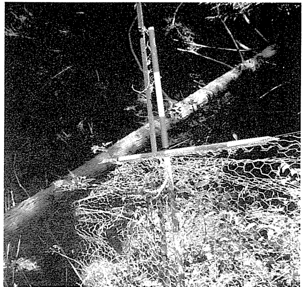
図12 倒木によって破損した防護柵 (網が破損しているだけで、支柱もほとんど倒壊することがある。破損箇所はシカの通路となるので修理が必要。)
