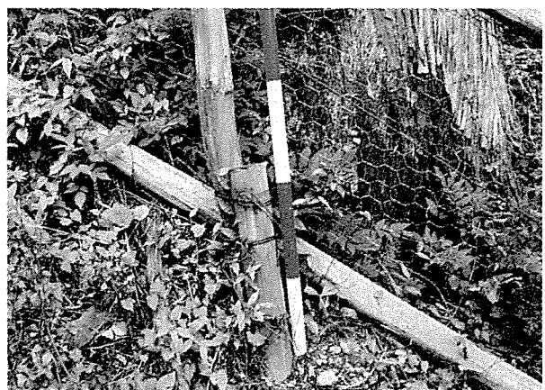
図2 六角形金網、木製支柱が使用されている防護柵（支柱や網のアンカーに間伐材等の木材が使用されている。）
