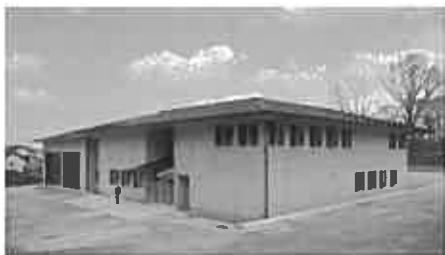
奈良公園事務所(内外装木質化)
