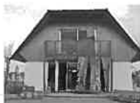
十津川産材を使用したモデル住宅
