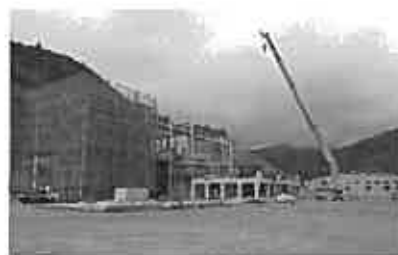
木質バイオマス発電所(建設中)
