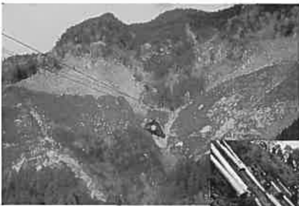
皆伐施業地からの架線集材状況
