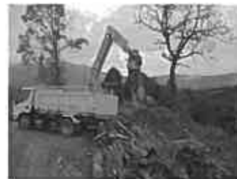
C材の搬出状況
