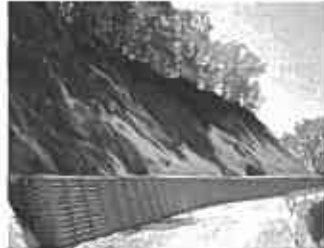
木製校倉擁壁の施工例
