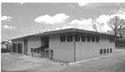
奈良公園事務所 (内外装木質化)
