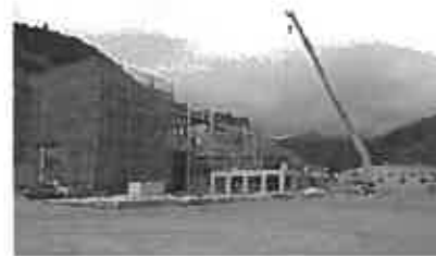
木質バイオマス発電所(建設中)
