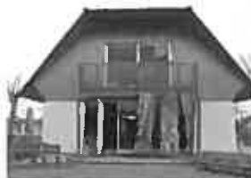
十津川産材を使用したモデル住宅
