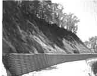
木製校倉擁壁の施工例
