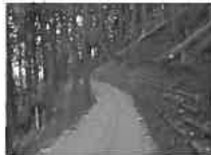
作業道整備完了
