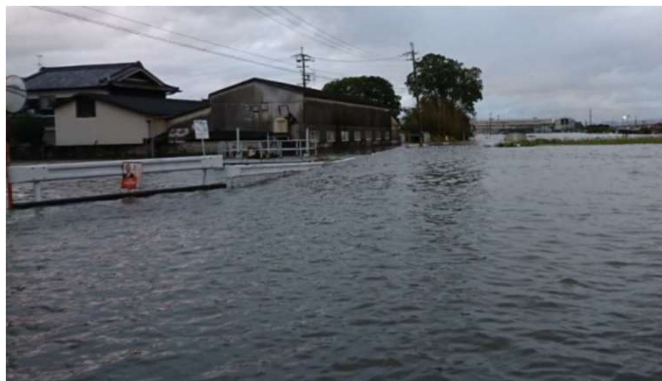
<平成29年10月 内水はん濫の状況 広陵町>
