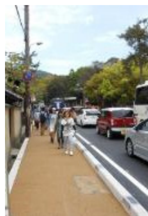
奈良公園内歩道整備
