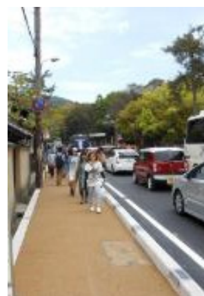
奈良公園内歩道整備
