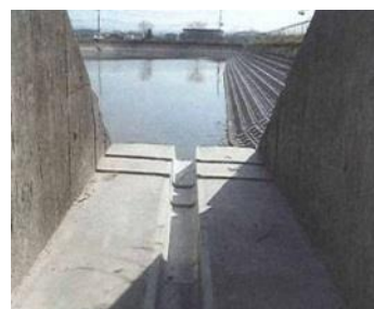
余水吐に切欠設置 磯野池（大和高田市）
