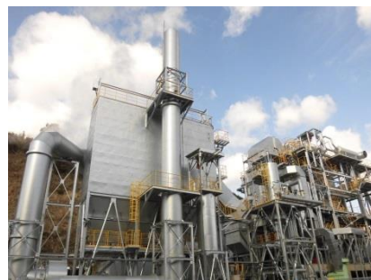
木質バイオマス発電施設
