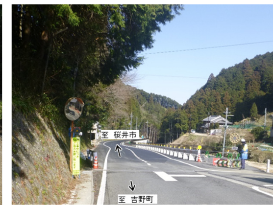
百市工区(部分供用状況)
