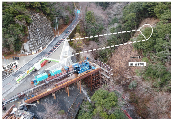
伯母峯峠道路(仮称)2号橋 (橋梁下部工事)
