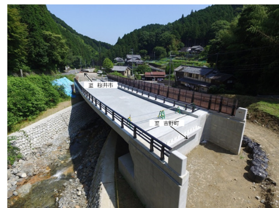
百市工区(橋梁上部工事)
