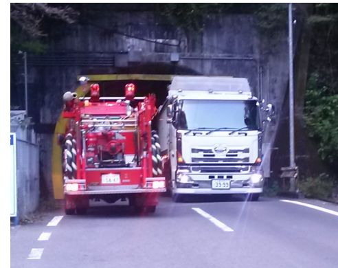
新伯母峯トンネル(現道) (大型車のすれ違い状況)
