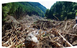
平成23年紀伊半島大水害における山地災害
