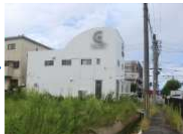
撤去後(H30.8撮影)
