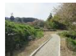
遊歩道の整備(R2.3) (撮影:R2.3)
