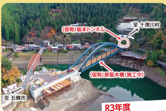
国道168号 阪本工区
