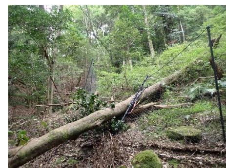
植生保護柵の破損状況
