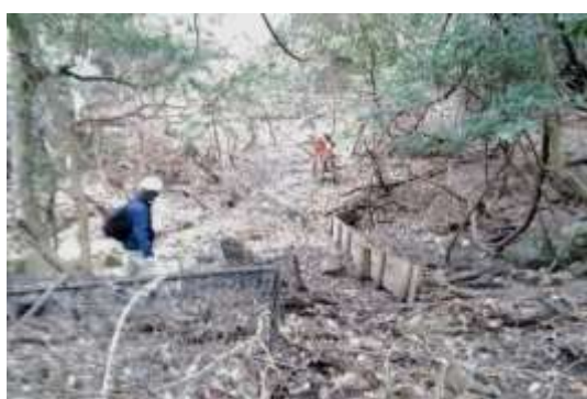
図 5 支柱の破損と土砂の流出（春日山 16-2）【令和元年度（左）、令和 2 年度（右）】
